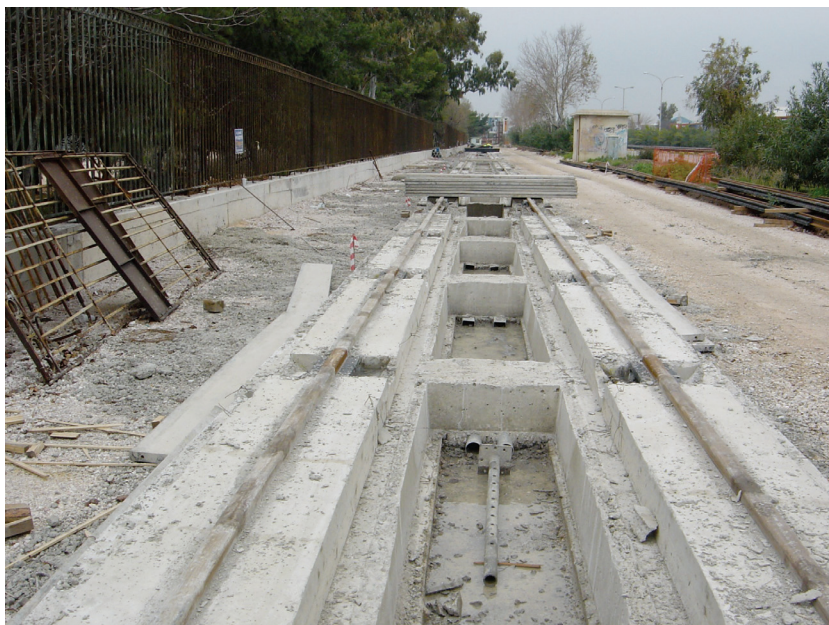
1. ábra. Külföldi példa pályagerenda kialakítására
