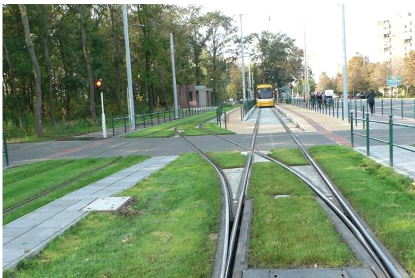
8. ábra. A 2-es villamosvonal füvesített kitérője
