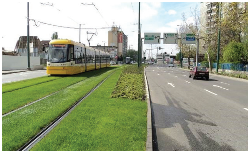
6. ábra. Szeged 2-es villamosvonal füvesített kialakítása
