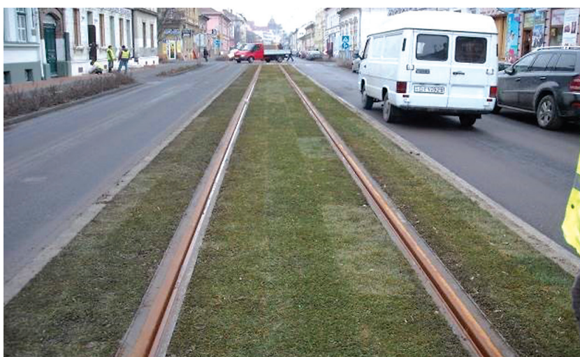
10. ábra. A 3-as villamos egyvágányú füvesített pályaszakasza
