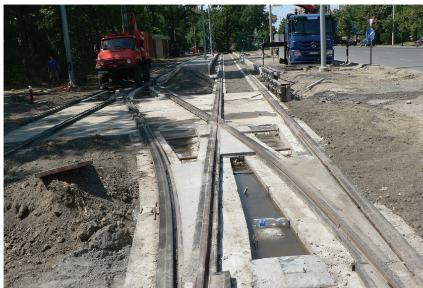
7. ábra. A 2-es villamos füvesíthető kitérője humuszolás előtt
