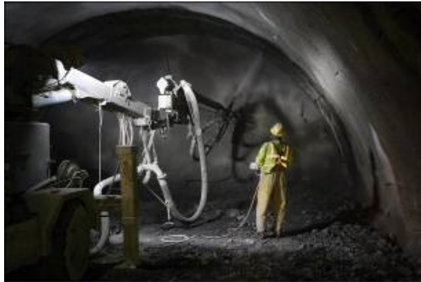
28. ábra: szintetikus szálerősítésű löttbeton készítés közben, Devil's Slide, Kalifornia
