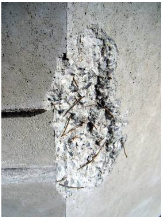
2. ábra: acél szál erősítésű beton sérülés utáni rozsdásodása (a szerző felvétele)
