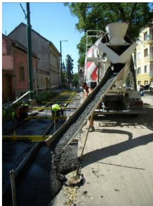
32. ábra: szegedi villamospálya kivitelezés közben
